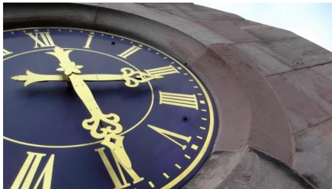
4b: 12.03.19: Beispiel einer »Vierung« - Austauschstein an der Westfassade der Uhr. Wild startet Einrüstung
