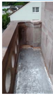
5: Kupferblech für den Balkonboden
