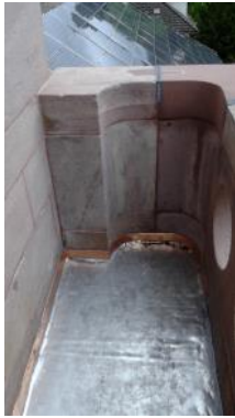
5a: Kupferblechauslegung mit Bleiverplombung am waagrecht-rechten Rand
