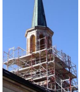
10: Gerüstabbau durch Fa. Wild, Eimeldingen
