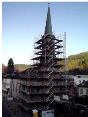
2: 29.03.019: Das Gerüst steht!
