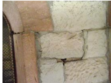
Bild 5: Zementfugen
