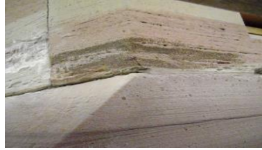
Bild 3: Alte Mörtelergänzungen
