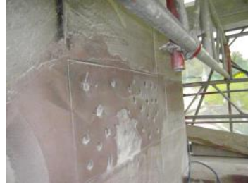
Bild 4 : Verfüllungen
